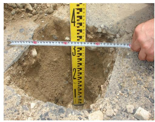
**橋面舗装は50mm程度の舗装の下に200mm程度の土砂が見られた。**橋面防水や橋面排水は見られないため、舗装下に入った雨水は床版の水抜き穴?より桁下へ流れ、それが主桁や床版へ悪影響を及ぼしている。また、土砂によって保水された水が、長期にわたって、桁下への水を供給していたものと思われる。
