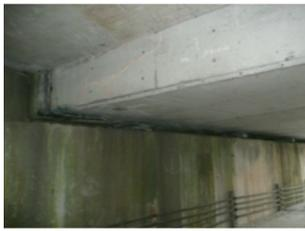
橋梁上部の路面からの漏水状況と、その漏水が原因で鉄筋腐食によるコンクリートの剥離状況
