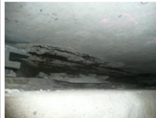
床版の中央付近漏水が原因による部分的な鉄筋の腐食とコンクリート剥離が見られる。
