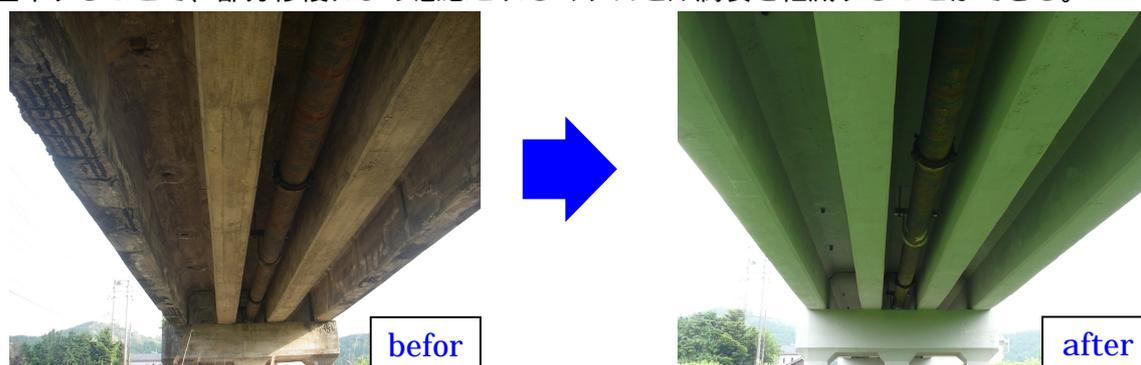
なお、表面含浸工だけでは、補修をしたことがわかりづらいとの理由から、発注者の要望により含浸材の上から表面塗装を施工した。また、水処理が必要であるため、原因となった穴の閉塞や舗装下の土砂を撤去し、橋面高を下げ、橋面防水工等を実施した。
